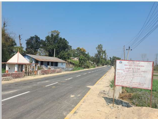
राँझा-राजापुर (बाँके-बर्दिया) मध्यमार्गी लोकमार्गको दौलतपुरघाट देखी सैजनाघाट पर्सेनीबजार सडक खण्ड सडक (निर्माणाधीन)
